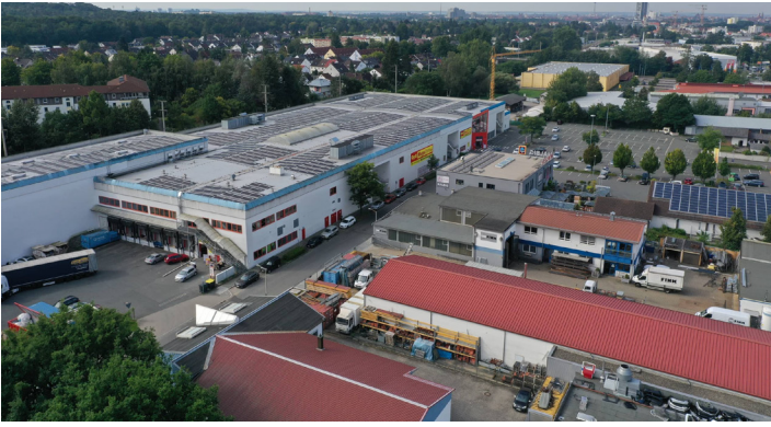
Standort Nürnberg: Solaranlage mit überdurchschnittlichem Stromertrag, errichtet mit dem österreichischen Solarentwickler CCE
